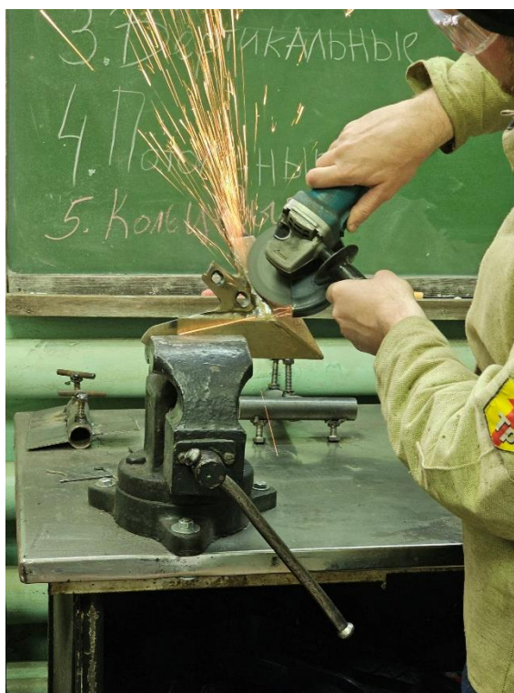
Рисунок 5.8 – Зачистка сварных швов после приварки пластин
