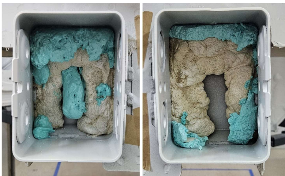
Рисунок 2.22 – Доработка герметизации элементов кузова после проведения замеров
