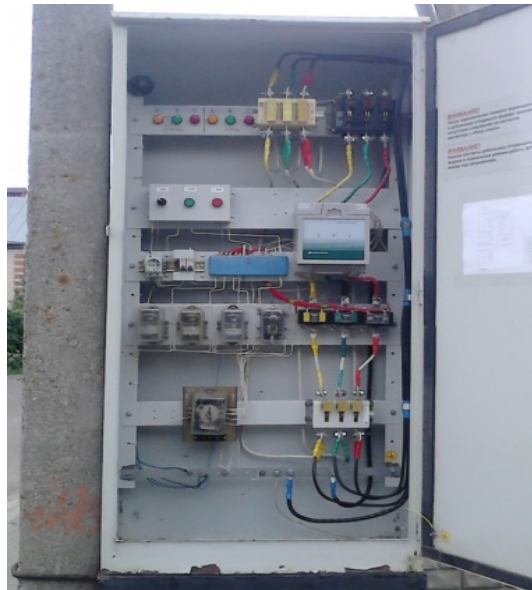
Рисунок 3.1- Секционирующий пункт для линий электропередачи напряжением 0,4 кВ
