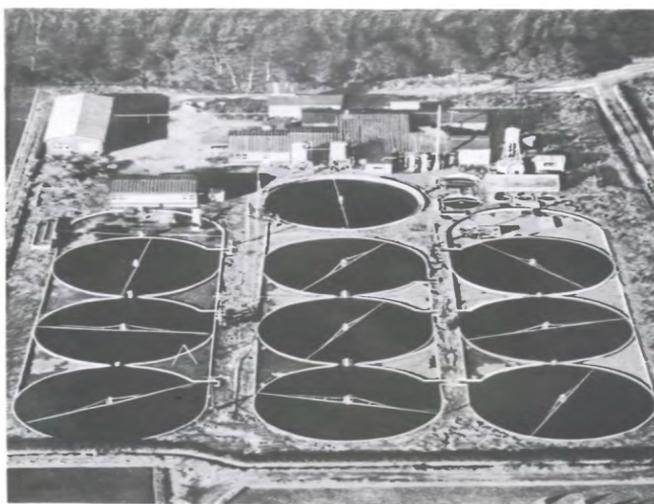
Рисунок 1.3 - Комплекс установок «под открытым небом» для массового производственного культивирования одноклеточных водорослей (Япония).
