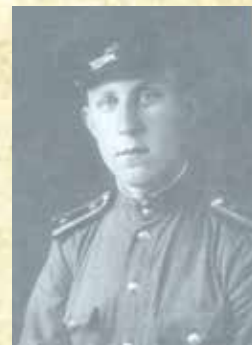
1943 г. - курсант военно-инженерного училища
